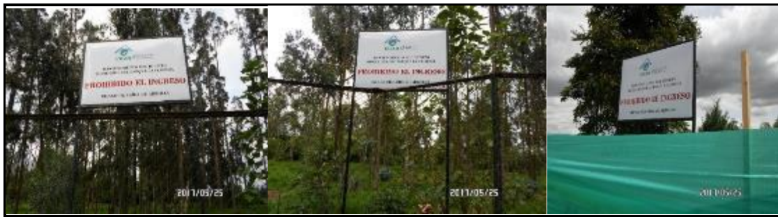
Fotografías 23 a 25. Instalación de vallas de señalización.
