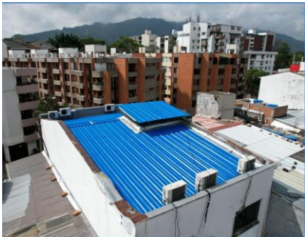
Fuente: Informe de Obra No.3 del contratista
