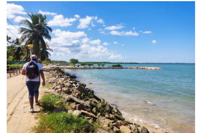
► Figura 2.99. Obras duras sobre la línea de costa en Playa Blanca
