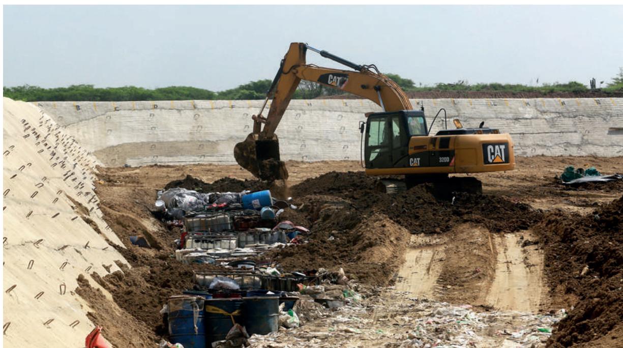
Disposición final de Respel en celda de seguridad. Cortesía. Minambiente
