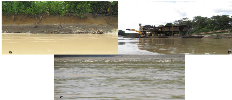
Figura 20. A,b,c, afectaciones de las condiciones y el estado del río Quito
