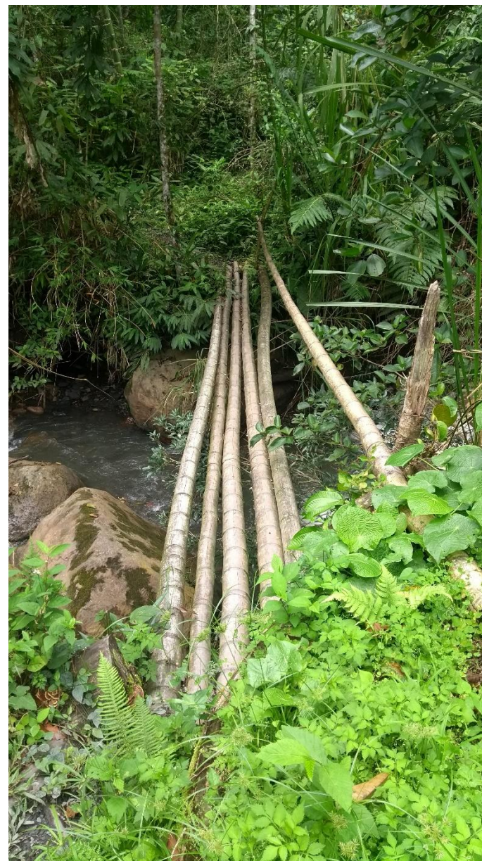
Fotografía 2. Uso de la Guadua ( Guadua angustifolia ) para la construcción de puentes rurales en el municipio de Maripí, Boyacá. Fuente: David Pérez, 2020.
