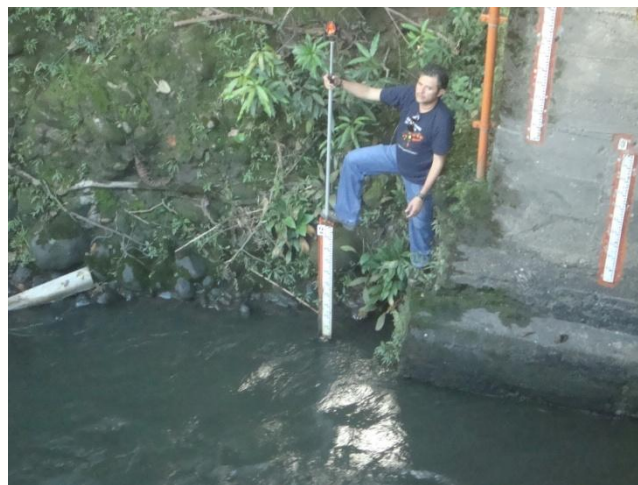
Nivelación topográfica cota cero miras IDEAM.
