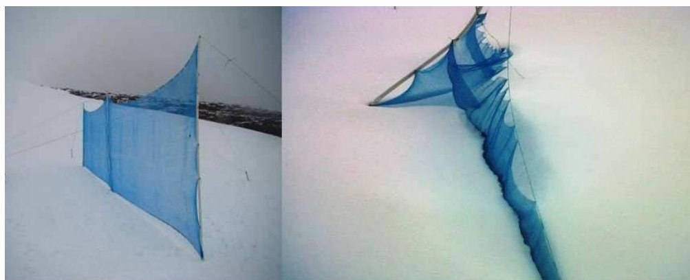
En noviembre de 2011 se instaló la valla interceptora de nieve
