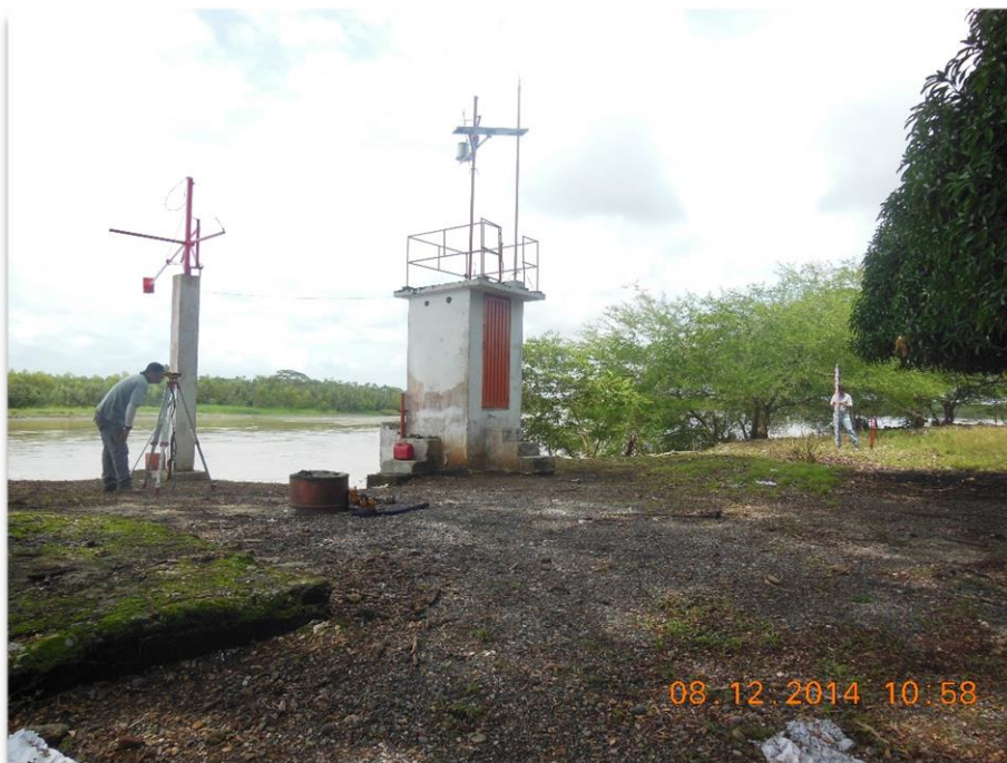
Foto 9 Nivelación Estación La Coquera
