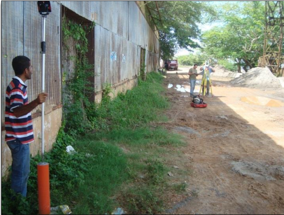
Foto 6. Nivelación del BM de estación hidrológica del IDEAM
